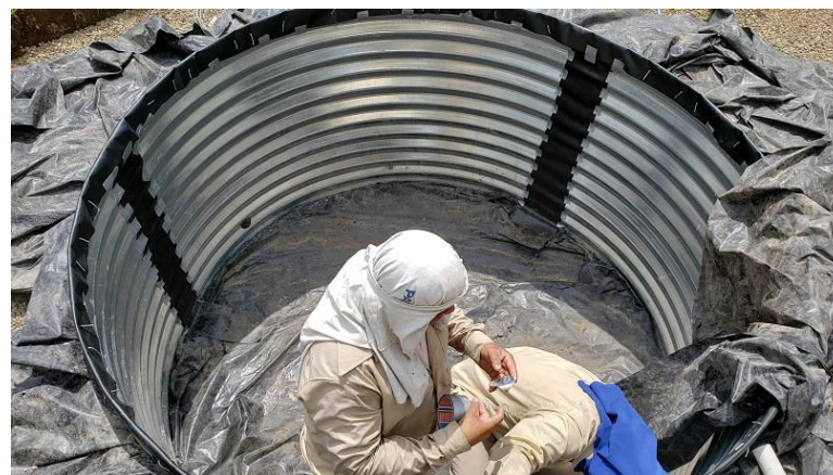
8. Instalación del tanque de drenados
