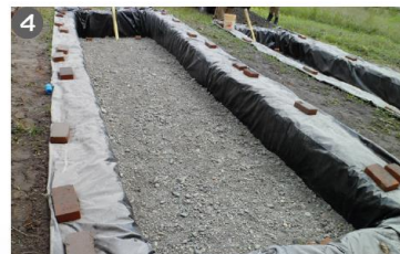
Adición de la capa de arena
