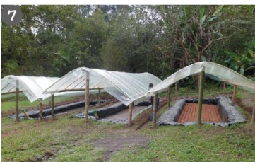
Aspecto final de los lechos de secado
