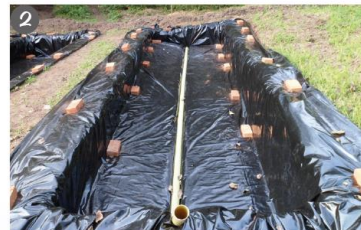
Impermeabilización de los lechos de secado
