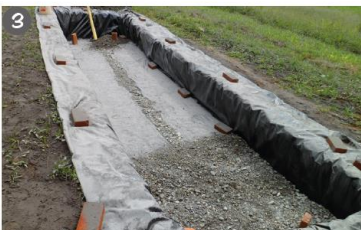
Adición capa de grava
