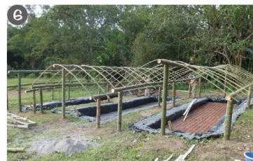
Construcción del techo para los lechos de secado
