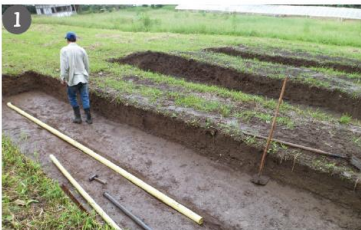
Excavaciones y ubicación de tubería de aireación
