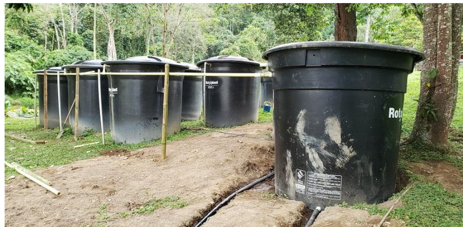
6. Canalización del agua del SMTA al FV
