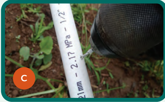
Figura 25. Instalación del sistema de riego. a. Corte y acoplamiento de los tubos que conformaron cada línea de riego; b. Instalación de las llaves de paso al ingreso de cada una de las líneas de riego; c. Perforación de los tubos de conducción para la salida del agua por goteo; d. Aspecto final de las cinco líneas de riego.
