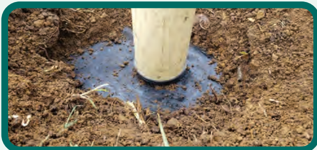
Figura 82. Aspecto del tubo PVC-S que contiene la guadua de soporte del techo.
