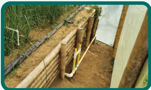
Figura 118. Salida de drenados del filtro verde y su recolección en tanques de polietileno para ser reincorporados al mismo mediante bombeo a la unidad de aplicación.
