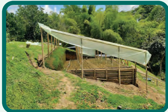
Figura 87. Aspecto final de la siembra del pasto vetiver con camino central, sin siembra, de 60 cm de ancho, para favorecer las labores de mantenimiento.
