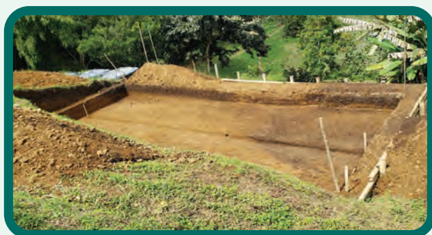
Figura 75. Excavación del área delimitada del filtro verde hasta 0,7 m de profundidad.
