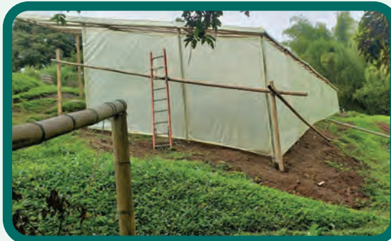
Figura 115. Techado del filtro verde y cubrimiento de las paredes con plástico.
