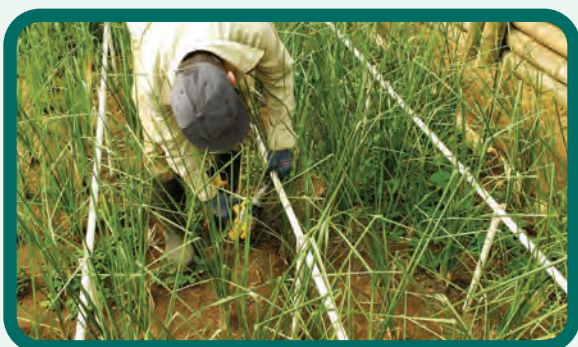
Figura 117. Instalación de la tubería de riego para la aplicación del agua residual tratada.
