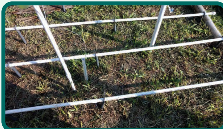
Figura 93. Aspectos de los soportes para la nivelación de la tubería de riego.
