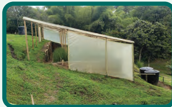
Figura 118. Salida de drenados del filtro verde y su recolección en tanques de polietileno para ser reincorporados al mismo mediante bombeo a la unidad de aplicación.
