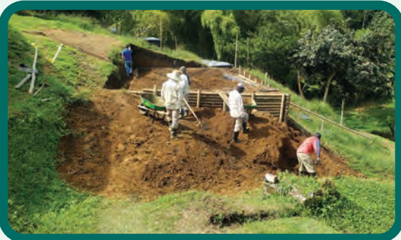
Figura 114. Llenado de la excavación impermeabilizada con suelo estratificado, conservando su perfil original.
