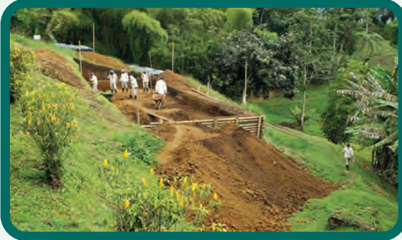
Figura 113. Excavación de 70 cm de profundidad, impermeabilización del fondo de la misma con geomembrana de 20 mils e instalación del tubo de aireación y descarga de drenados.
