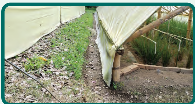
Figura 127. Construcción de canales de escorrentía alrededor de los filtros verdes.
