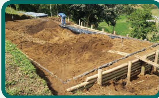
Figura 114. Llenado de la excavación impermeabilizada con suelo estratificado, conservando su perfil original.
