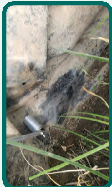
Figura 133. Aspecto de la geomembrana reparada.
