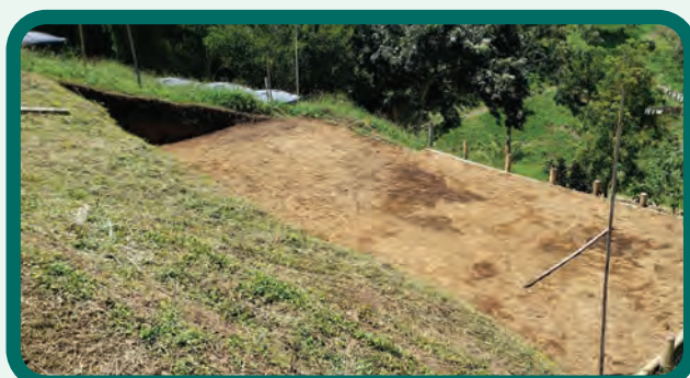
Figura 74. Delimitación y aplanamiento del área para la construcción de un filtro verde.
