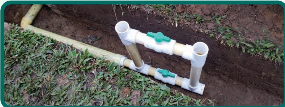
Figura 95. Esquema del sistema de control de inundación del filtro verde.
