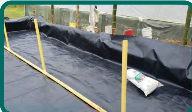
Figura 79. Aspecto de la instalación de los tubos verticales de aireación acoplados a la tubería de aireación y conducción de drenados.
