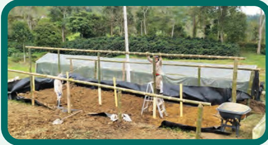
Figura 84. Aspecto de la estructura del soporte para el techo del filtro verde.
