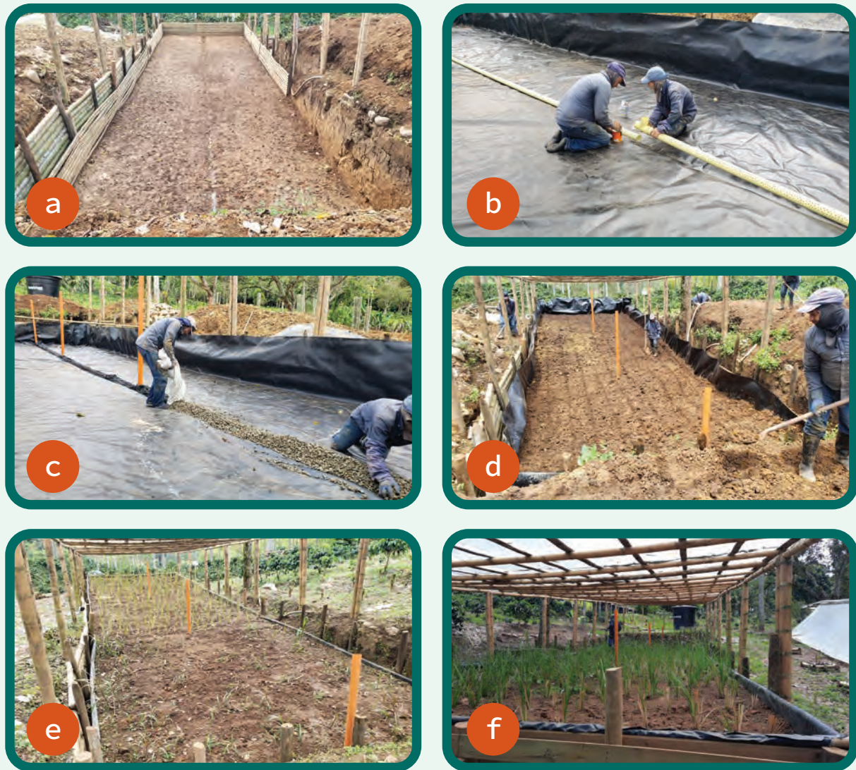
Figura 120. Instalación del filtro verde (ZLD) en la Estación El Rosario. a. Excavación y delimitación del terreno utilizando guadua; b. Impermeabilización del suelo de la excavación con geomembrana de 20 mils e incorporación de tubos de aireación a la tubería de drenaje (1 tubo cada 3 m); c. Cubrimiento de la tubería de drenaje con polisombra y gravilla; d. Llenado de la excavación con el mismo suelo extraído y conservando su perfil original; e. Siembra del pasto vetiver; f. Aspecto general del filtro verde en funcionamiento.
