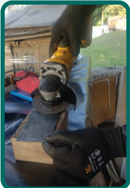
Figura 129. Lijado y limpieza de un pedazo de geomembrana para reparación de cortes.
