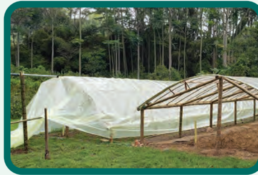
Figura 105. Construcción del techo de los dos filtros verdes.
