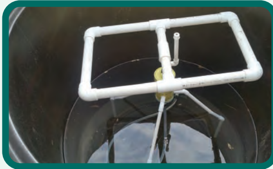
Figura 24. Dispositivo filtrador-regulador de caudal instalado en el tanque de distribución.
