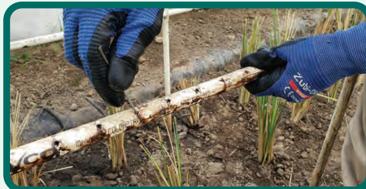
Figura 124. Limpieza y destaponamiento de la tubería de riego de los filtros verdes.
