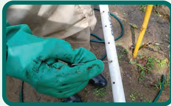
Figura 125. Lavado de la tubería de riego de los filtros verdes.
