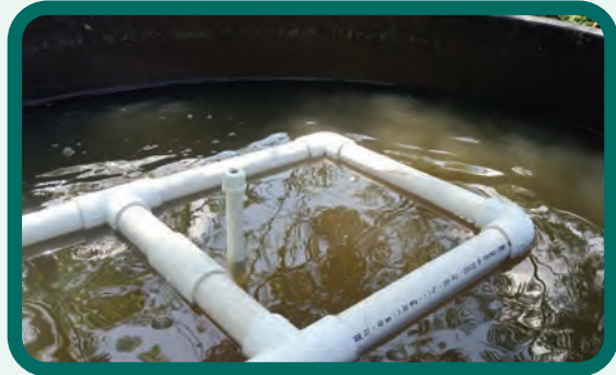
Figura 24. Dispositivo filtrador-regulador de caudal instalado en el tanque de distribución.
