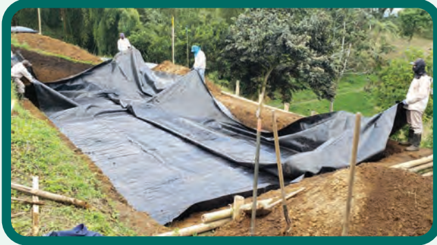
Figura 76. Instalación de la geomembrana para impermeabilizar la excavación del filtro verde.
