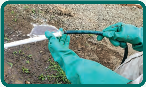
Figura 125. Lavado de la tubería de riego de los filtros verdes.
