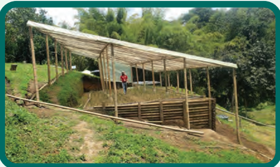
Figura 115. Techado del filtro verde y cubrimiento de las paredes con plástico.
