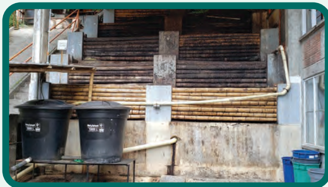
Figura 100. Tanques en polietileno que recolectan los lixiviados de la mezcla pulpa + mieles del Ecomill®.
