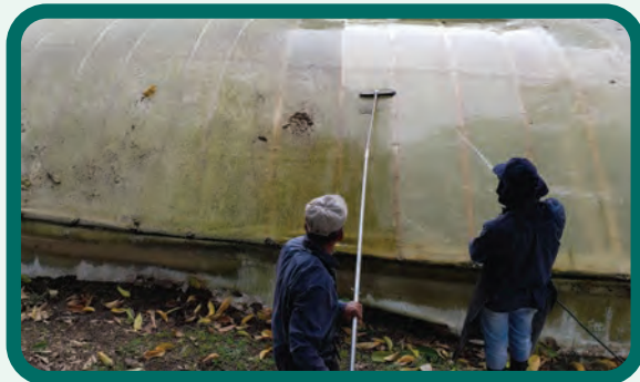
Figura 128. Limpieza de la cubierta plástica de los filtros verdes.
