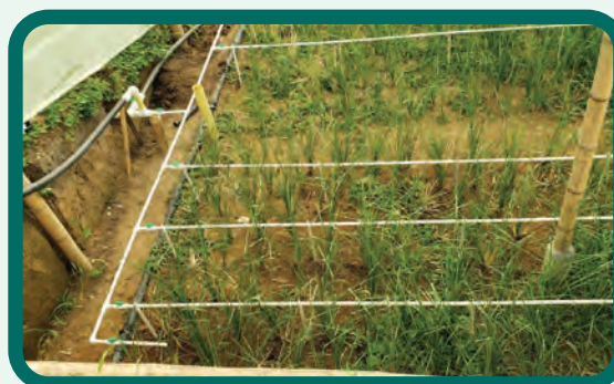
Figura 117. Instalación de la tubería de riego para la aplicación del agua residual tratada.
