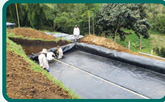
Figura 113. Excavación de 70 cm de profundidad, impermeabilización del fondo de la misma con geomembrana de 20 mils e instalación del tubo de aireación y descarga de drenados.
