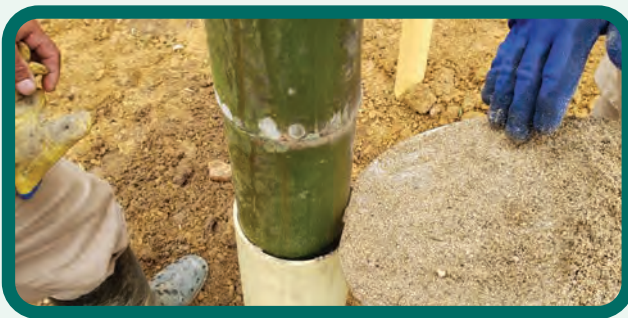
Figura 83. Relleno, con arena, del espacio vacío entre la guadua de soporte del techo y el tubo PVC-S que la protege de la humedad.
