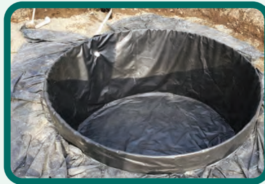
Figura 107. Instalación del tanque de recolección de drenados.
