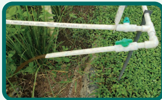
Figura 126. Eliminación de lodos de la unidad de aplicación de los filtros verdes.
