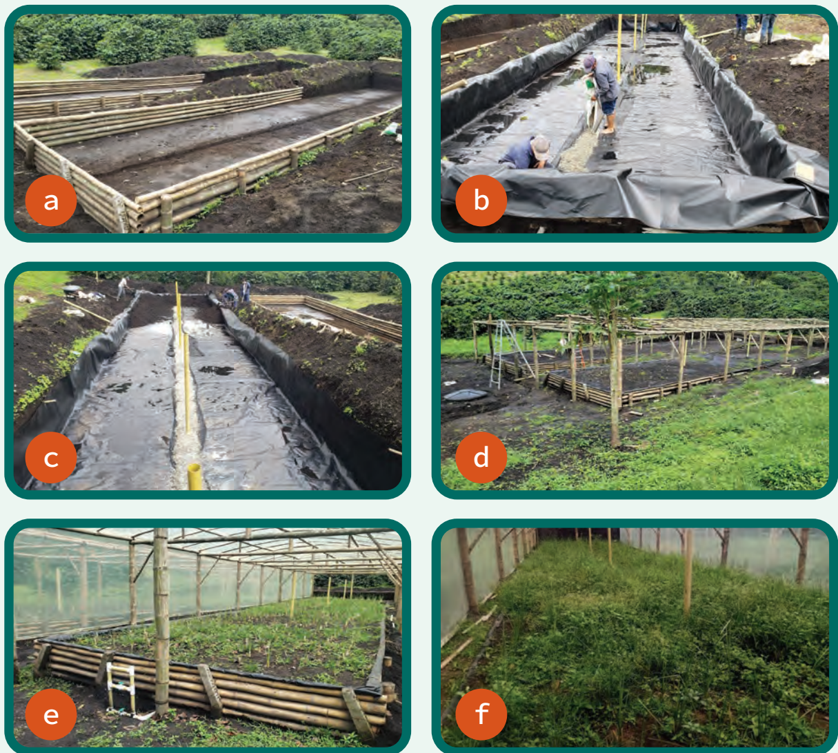
Figura 121. Instalación del filtro verde (ZLD) en la Estación La Trinidad. a. Excavación y delimitación del terreno utilizando guadua como trincho protector para evitar el derrumbamiento del suelo; b. Impermeabilización del suelo de la excavación con geomembrana de 20 mils; c. Incorporación de tubos de aireación a la tubería de drenaje (1 tubo cada 3 m); d. Aspecto general de la tubería de aireación y drenaje protegida con polisombra y gravilla para evitar el ingreso de partículas de suelo; e. Llenado de la excavación con el mismo suelo extraído y conservando su perfil original; f. Siembra del pasto vetiver.
