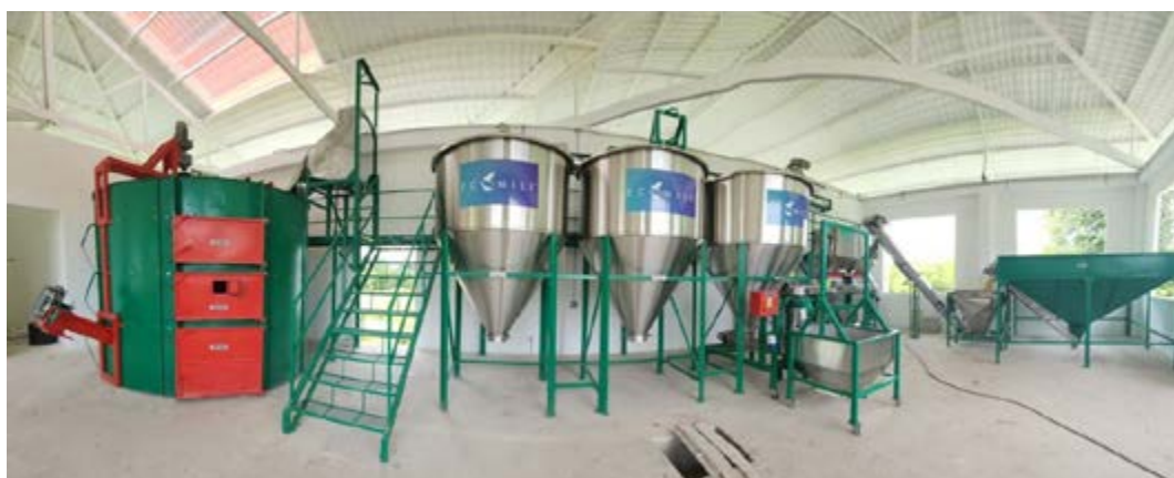
Figura 73. Panorámica del montaje de los equipos.
