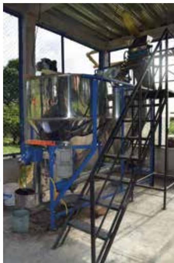
Figura 1. Beneficiadero ecológico comunitario típico construido en Pitalito (Huila). (a). Vista general del beneficiadero; (b). Modulo Ecomill® 1500.
