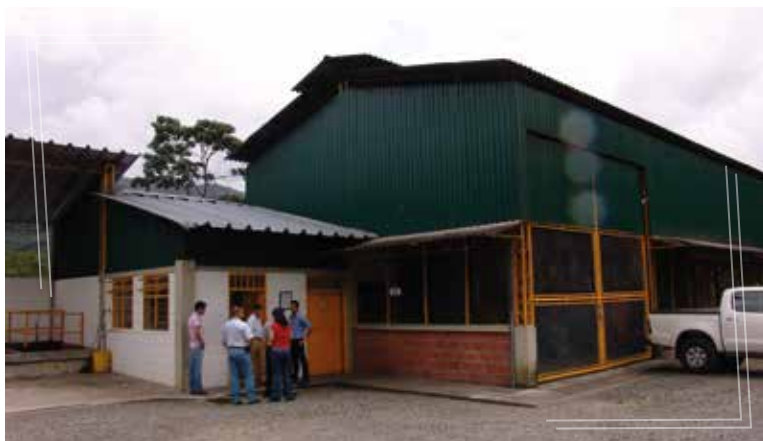
Figura 2. Vista general de la Central de Beneficio Ecológico de Anserma (Caldas).
