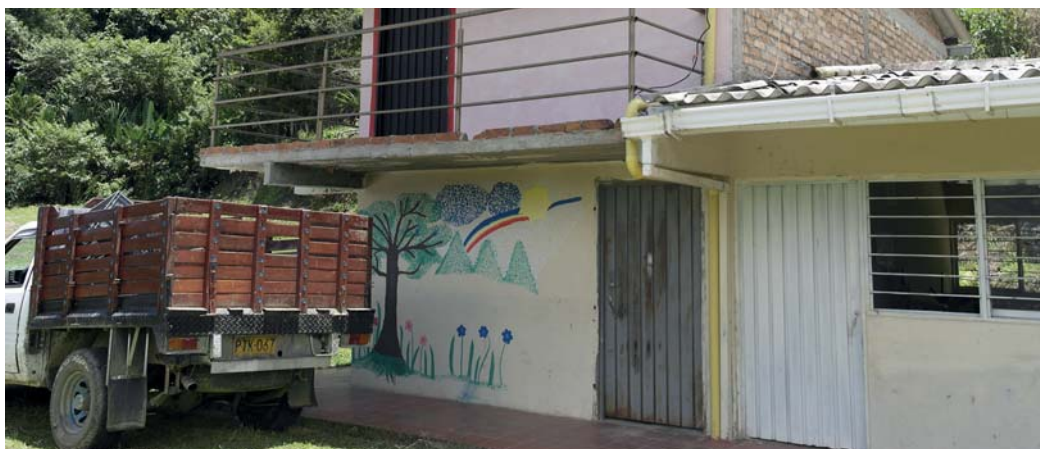
Figura 39. Conducción de agua lluvia (canal y bajante).
