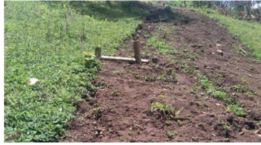
Figura 41. Filtro con soporte cubierto con material del área circundante.
