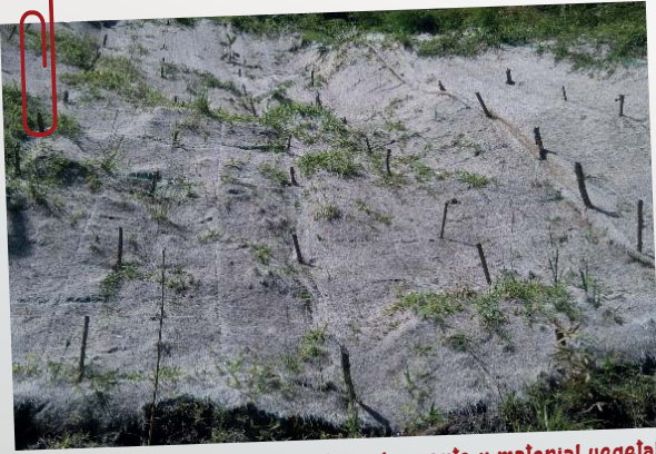
Cubrimiento de talud con biomanto y material vegetal
