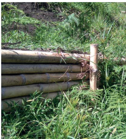
Figura 78. Terrazas escalonadas revegetalizadas.
