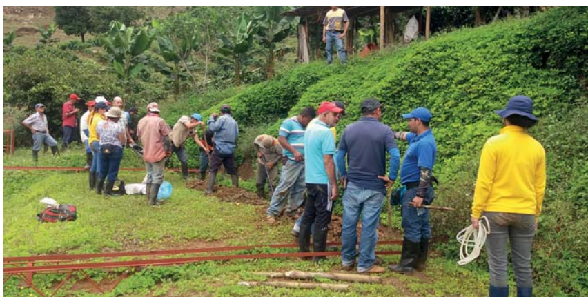
Figura 55. Realización de obras.
