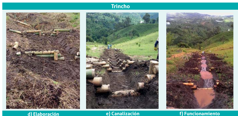
Figura 15. Trinchos con vertedero.
