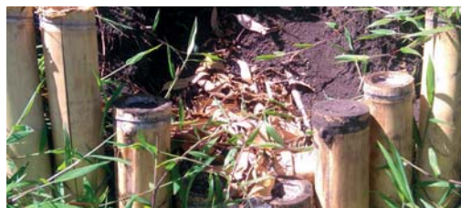
Figura 81. Trinchos con vertedero.
