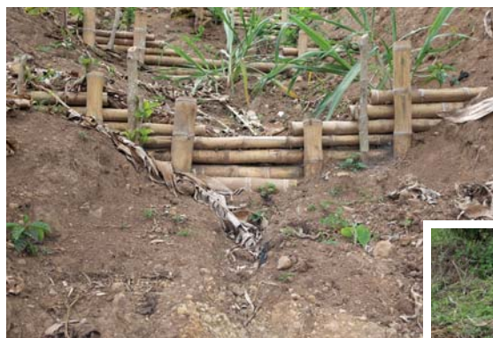
Figura 71. Trinchos con vertederos.
