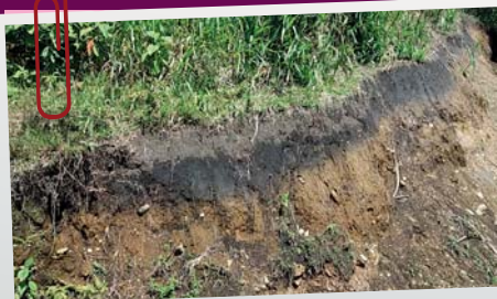
a). Perfilado del talud
