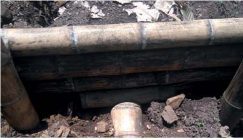
Figura 40. Filtros con soporte en proceso de construcción.
