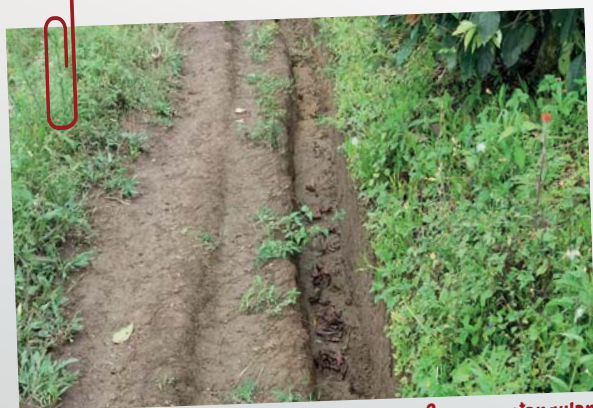
Cunetas en carretera de forma rectangular
