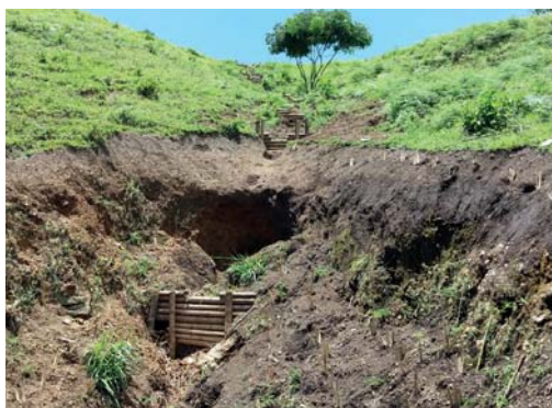
Figura 35. Perfilado del talud y barreras vivas.
