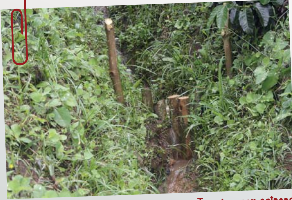
Trincho con estacas
