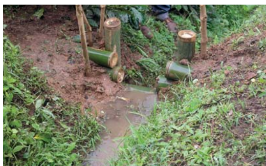
Figura 57. Trinchos con vertedero.
