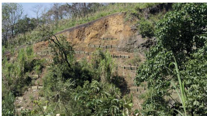
Figura 44. Perfilado del talud y terrazas en guadua.
