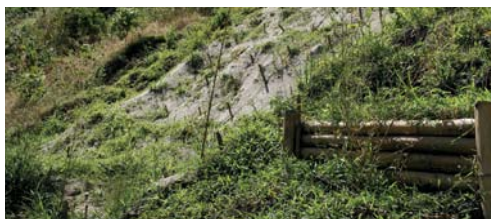
Figura 79. Recubrimiento con biomanto.
