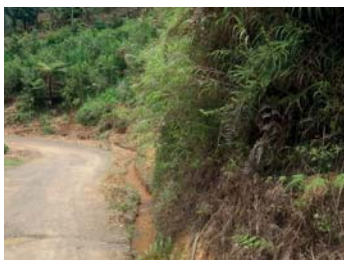
Figura 50. Canal en borde de carretera.
