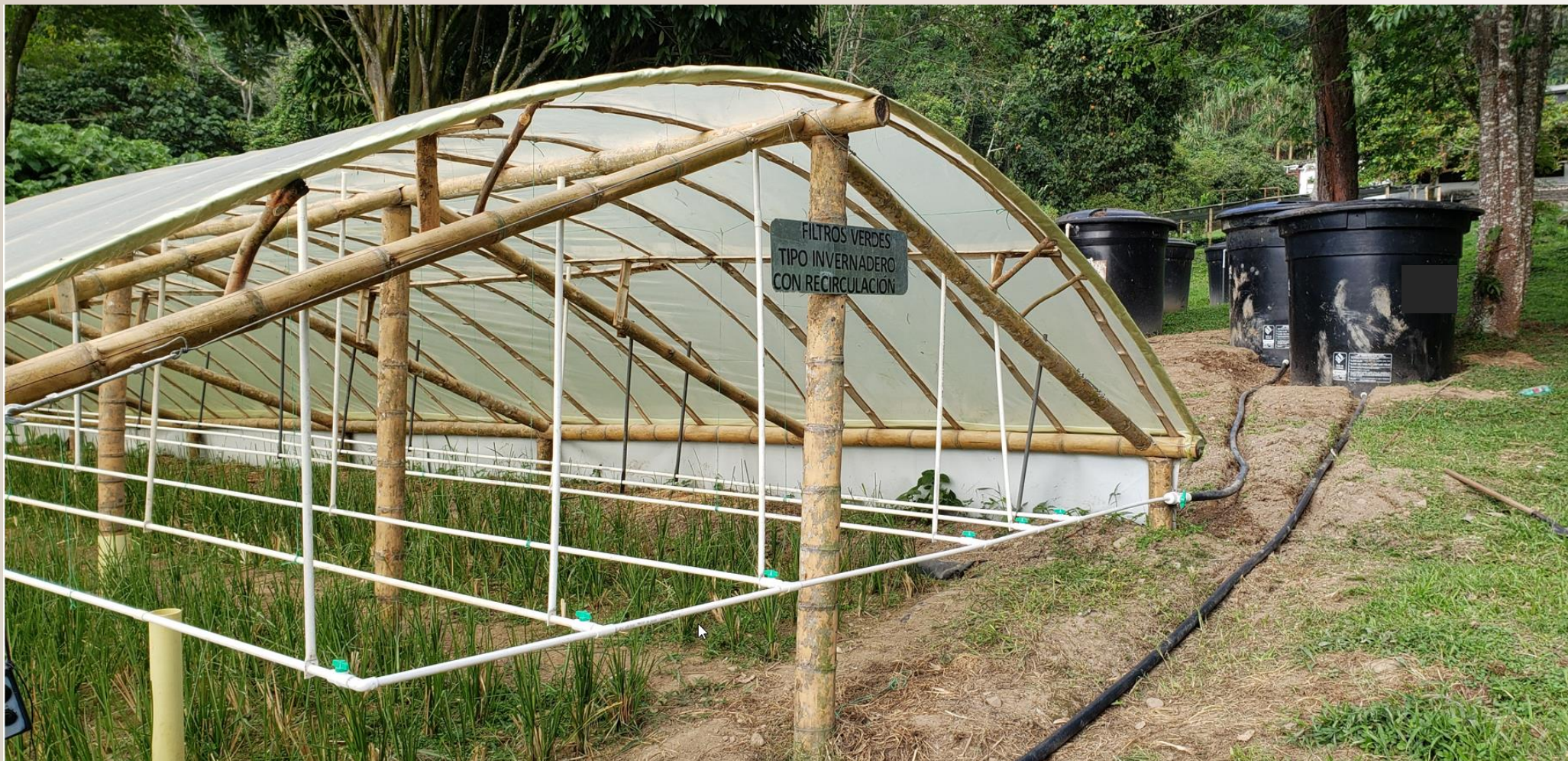
Filtro verde beneficiadero experimental Cenicafé. 200 m 2 10.000@ cps/año. Operando desde 2019
