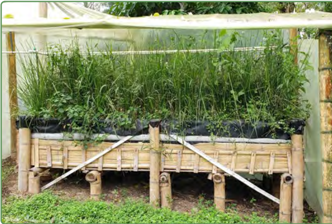
Figura 5. Filtro verde para el manejo de aguas residuales.
