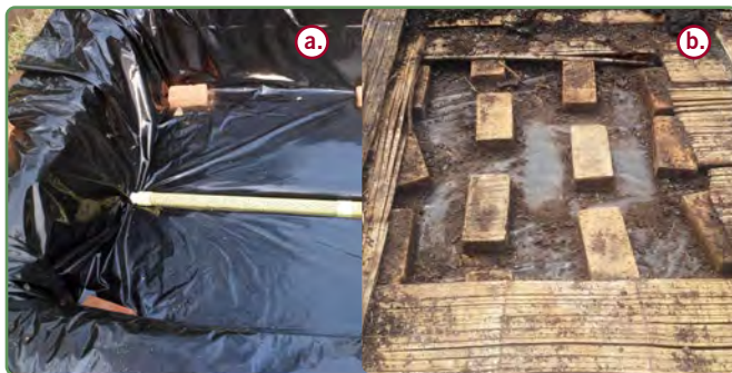
2. a. Impermeabilizar el suelo con plástico o geomembrana y b. colocar soporte para instalar un falso piso.
