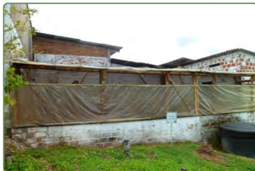
4. Forrar en plástico las paredes del procesador.
